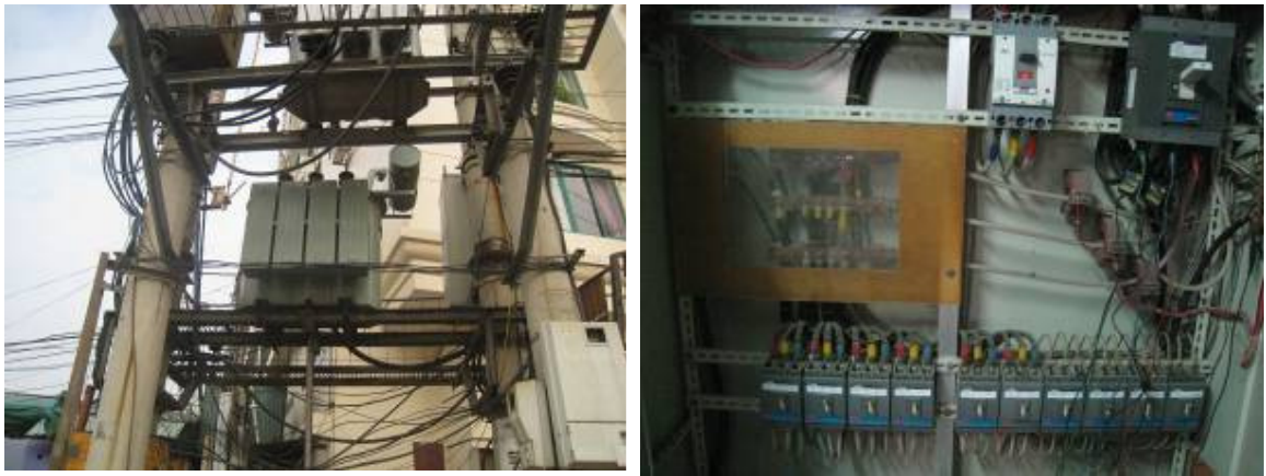
Hệ thống trạm biến áp tủ phân phối điện của tòa nhà
